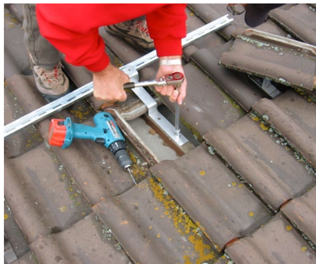
[ABB. 2] Vorbereitungsarbeiten für Aufdachinstallation.
