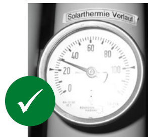
[ABB. 40] Thermometer mit geeigneter Abstandshülse verwenden.
