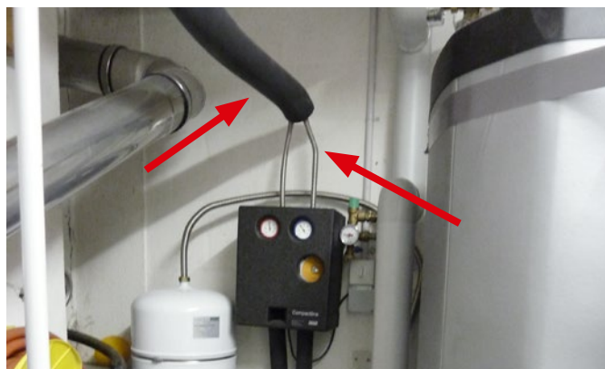
[ABB. 41] Dämmung bis in die Solarstation hineinführen.
