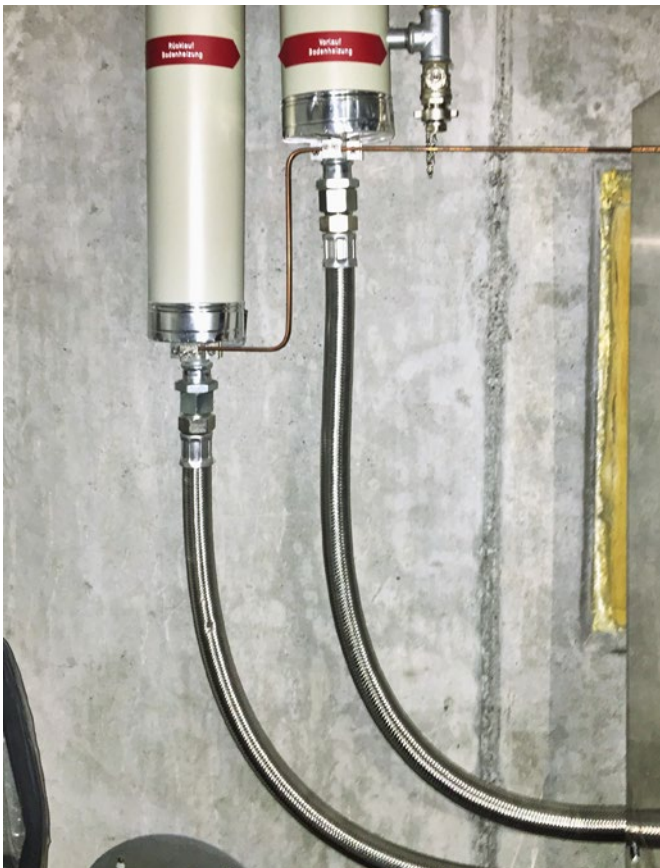
[ABB. 1] Wärmepumpe mit nicht sauerstoffdichten EPDM-Anschlüssen.
