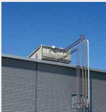
Bild 5.27: Direktverflüssiger- Prinzip als Installationsbeispiel.
