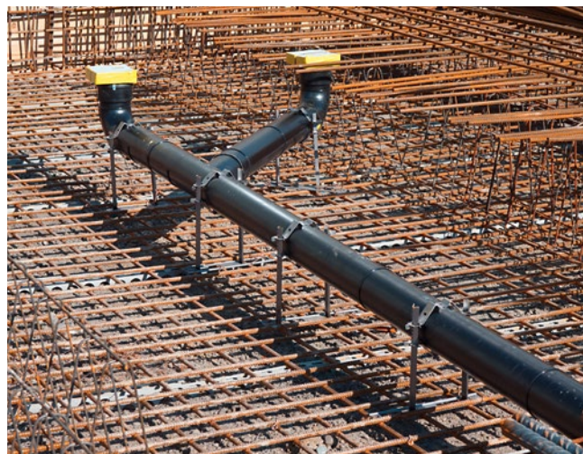
[ABB. 1] Beispiel Einlegerohrschelle für Sichtbetondecken (Bildquelle: SAMVAZ SA).
