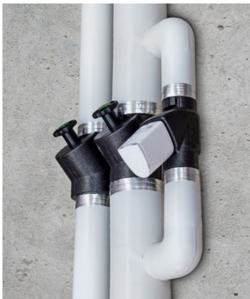
[ABB. 8] Steigzone mit RaR-Zirkulation und elektronischem Reguliertventil.
