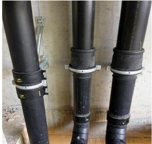
Jede Elektromuffe wird handschriftlich und persönlich durch den ausführenden Installateur mit seinen Initialen versehen. Die Kennzeichnung der Elektromuffe erfolgt unmittelbar nach der Schweissung.
