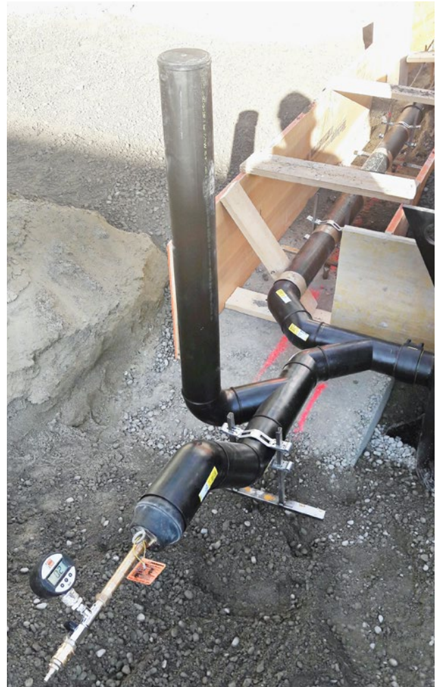
Abb. 2: Druckprobe Grundleitungen
