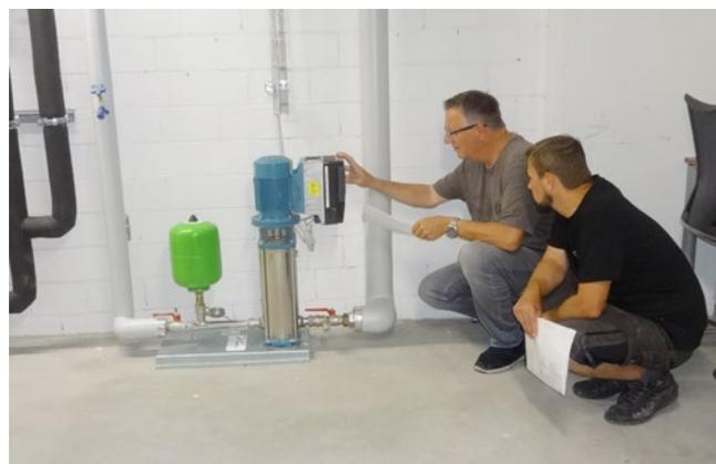
**[ABB. 3]** Nach den Vorgaben der Trinkwasserverordnung ist der Eigentümer/Betreiber der Trinkwasserinstallation für den ordnungsgemässen Betrieb der Anlage verantwortlich. Damit dieser seine Pflichten erfüllen kann, ist der Anlageersteller verpflichtet, den Eigentümer/Betreiber in die Anlage einzuweisen. Dies beinhaltet die Übergabe der Anlagedokumente sowie eine Instruktion mit Einweisungsprotokollen.
