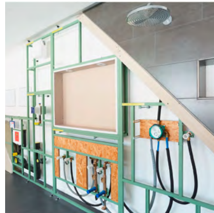
[ABB. 10] Vorfabriziertes und verrohrtes Sanitärsystem.
