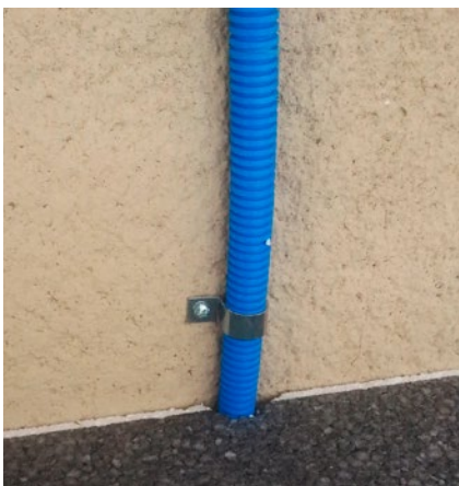
In der Wärmedämmung
