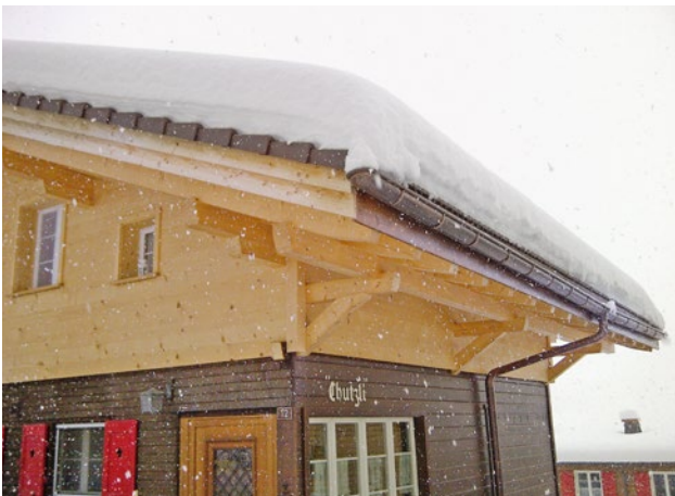
Bild 16: Vordach gedämmt, kaum Rückschwellwasser
