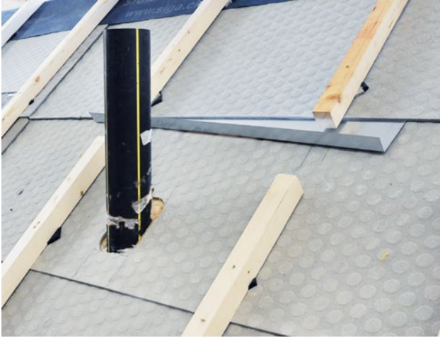
Bild 5: Abweisblech seitlich über die Konterlatten geführt
