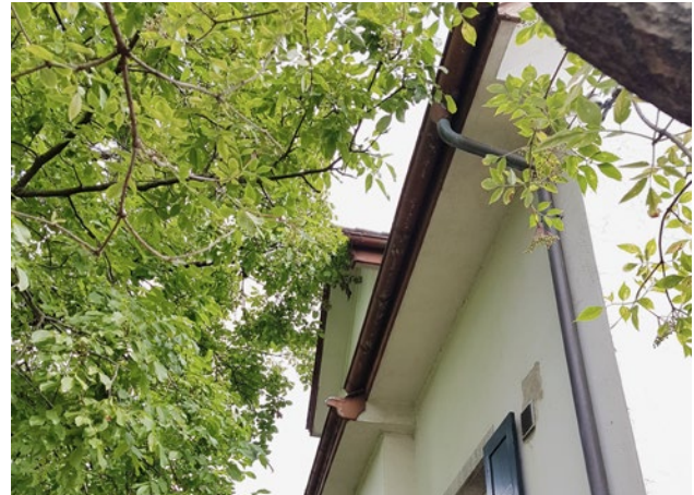
Bild 11: Empfindliche Gipsuntersicht
