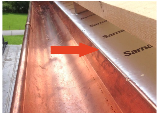
Bild 18: UV-beständige Folie/Bahn. Breite gemäss Tabelle auf Seite 8
