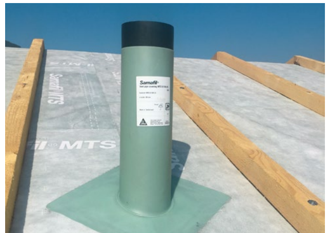
Bild 10: Formstück verschweisst
