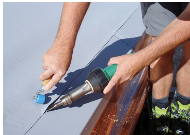
Bild 13: Unterdachbahn auf kaschiertem Einlaufblech. Stösse beim Einlaufblech sind zu verschweissen.
