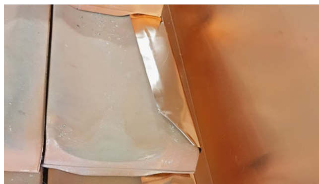
[ABB. 7] Anwendungsfälle für Bleilappen in der Praxis, als Ausführung mit legiertem Zink- oder Kupferblech in 0,3 mm Dicke.
