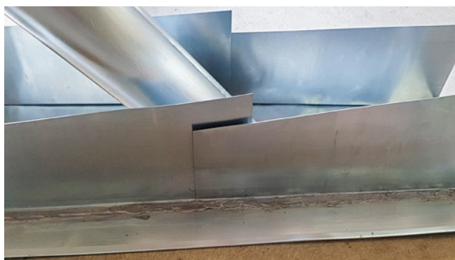
[ABB. 7] Anwendungsfälle für Bleilappen in der Praxis, als Ausführung mit legiertem Zink- oder Kupferblech in 0,3 mm Dicke.
