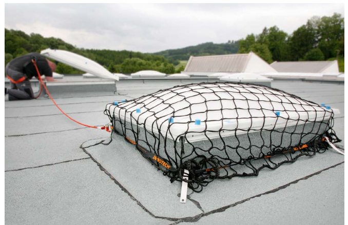
Abb. 39: Temporäre Lichtkuppelsicherung
