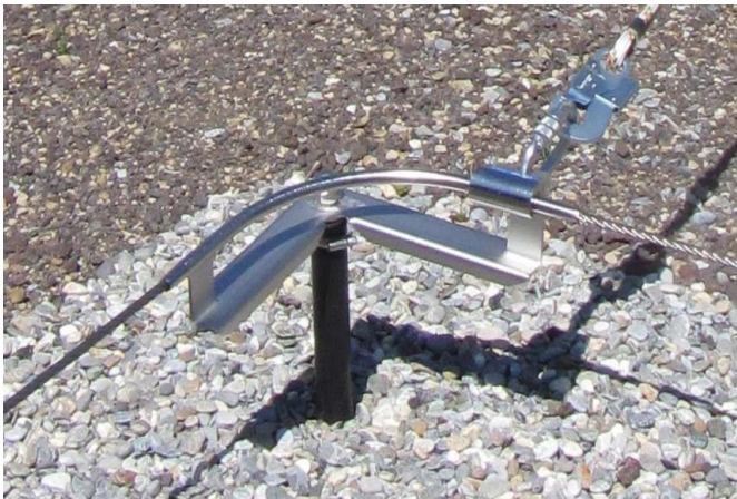
Abb. 17: Frei überfahrbarer Eckpunkt gemäss Herstellerangabe
