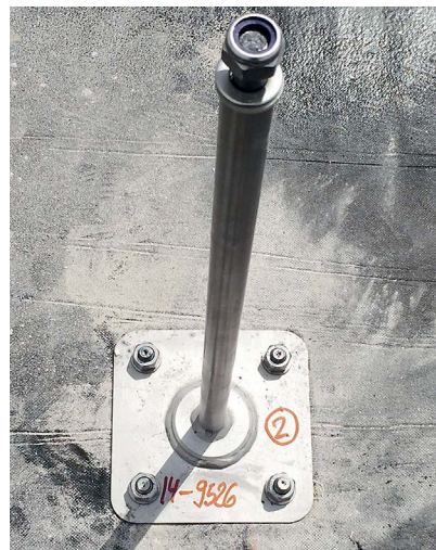
Abb. 41: Stütze fertig montiert und für die Montagedokumentation nummeriert (Objektnummer und Stützennummer)
