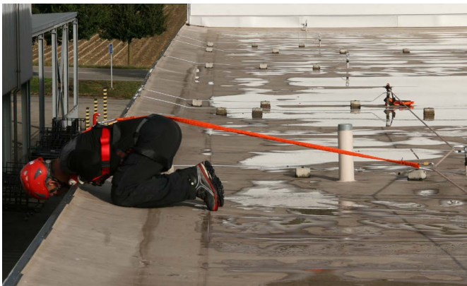
Abb. 9: Arbeiten mit Rückhaltesystem an temporärem Seilsystem
