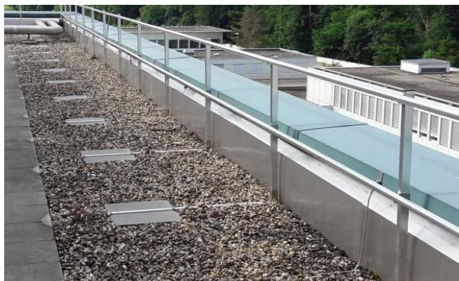
Abb. 24 Ausstattungsstufe 3: Seitenschutzsystem mit Auflast bodeneben montiert
