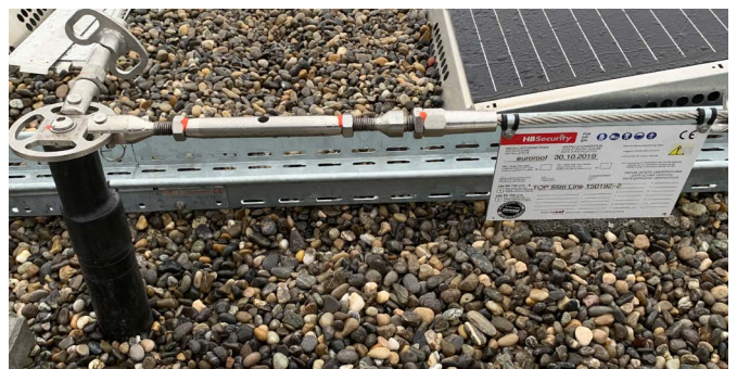
Abb. 42: Objektspezifische Kennzeichnung einer Seilanlage
