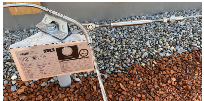
Abb. 43: Objektspezifische Kennzeichnung einer Seilanlage
