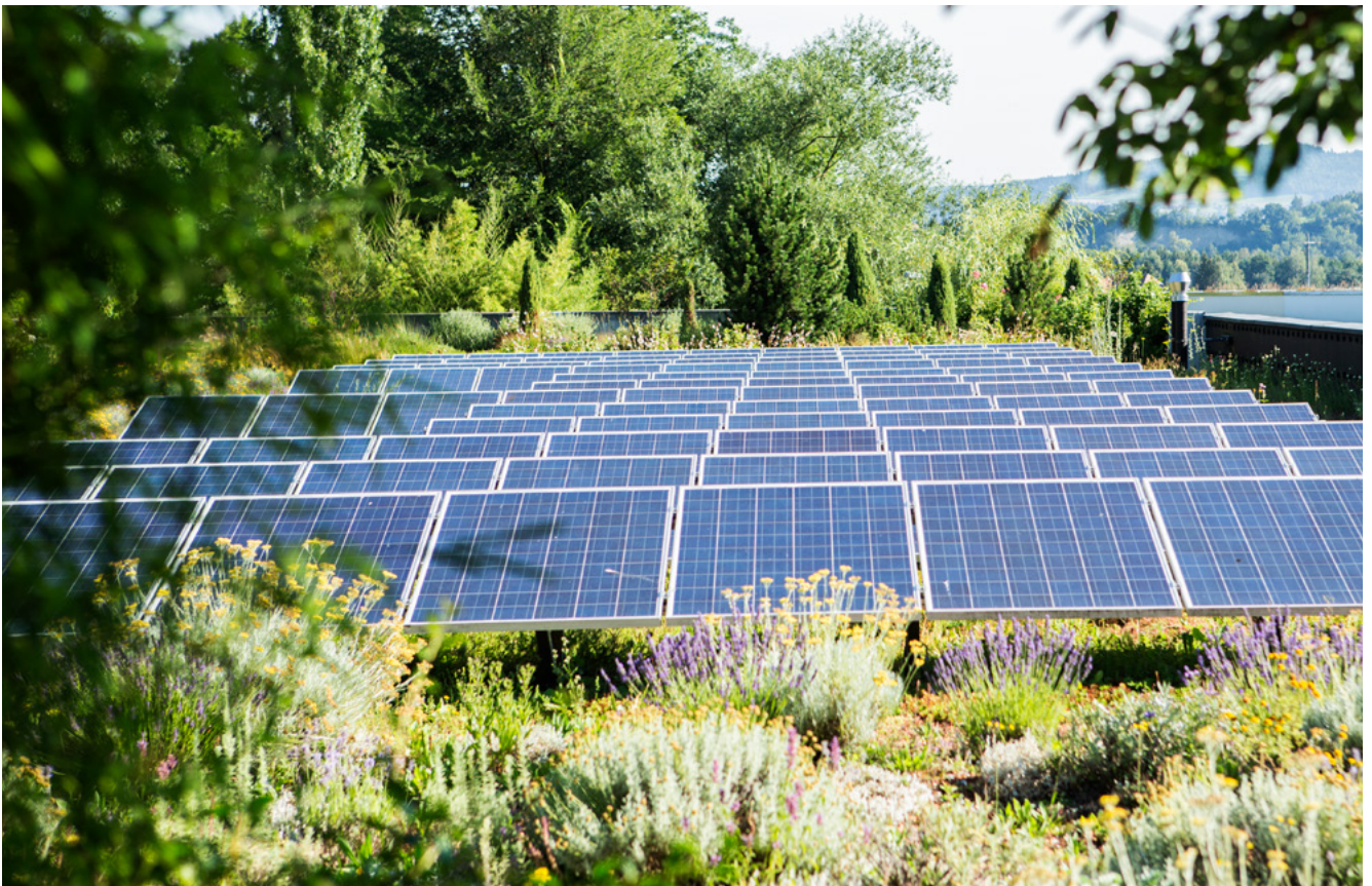
Abbildung 19: Intelligente Lösung in der Kombination von intensiver und extensiver Begrünung, zusammen mit einer Photovoltaik-Anlage, Quelle: contec
