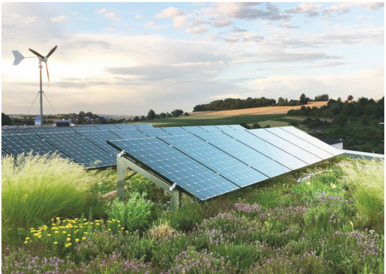
Abbildung 10: Kombination Intensiv-/Extensiv-Dachbegrünung neben PV-Anlage, Quelle: Zinco
