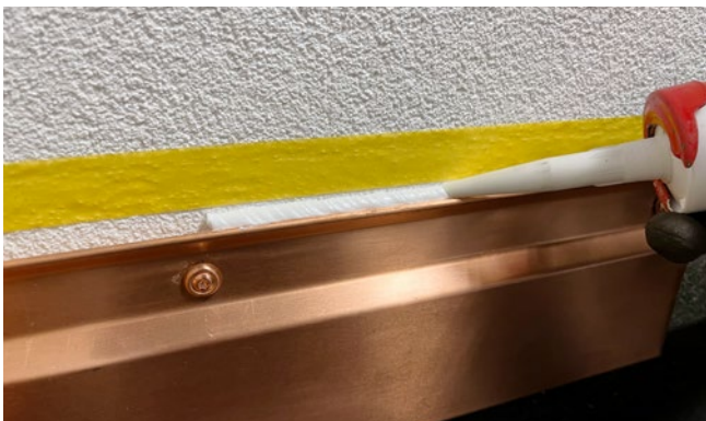
[ABB. 7] Der Dichtstoff wird mit Druck eingebracht. Dabei ist auf die richtige Düsengrösse – nicht zu klein oder zu gross abgeschnitten –, die Füllmenge und auf ein Gefälle des Fugenbords zu achten.
