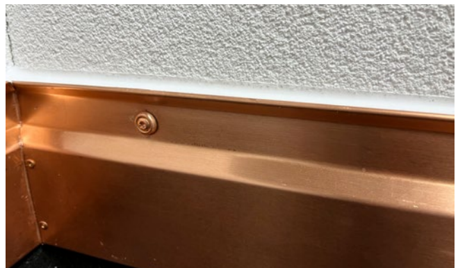
[ABB. 10] Das Abdeckband wird entfernt und die Blechteile von allfälligen Dichtstoff- oder Abglättmittelrückständen gereinigt.
