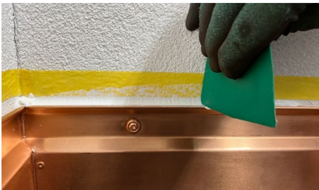
[ABB. 8] Der überschüssige Dichtstoff wird mit einem Fugenspachtel abgezogen.
