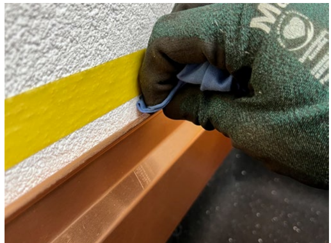
[ABB. 5] Die Haftflächen der abzufugenden Teile werden vorgängig und nach der Montage gereinigt. Sie sollten staub- und fettfrei sein.
