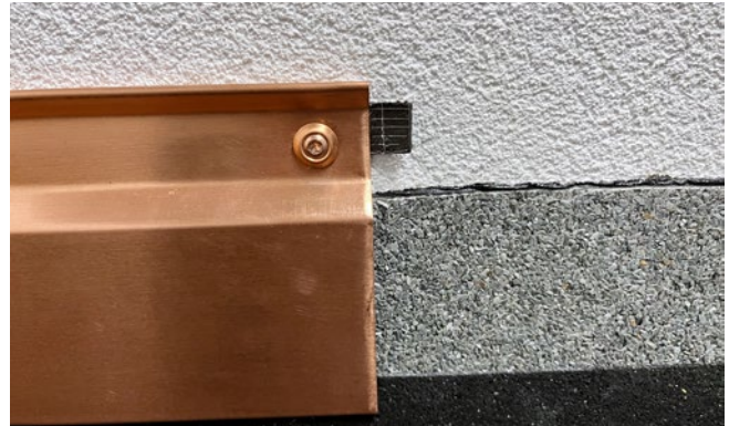
[ABB. 3] Das abzudichtende Anschlussblech wird mit einem Distanzband versehen und befestigt.
