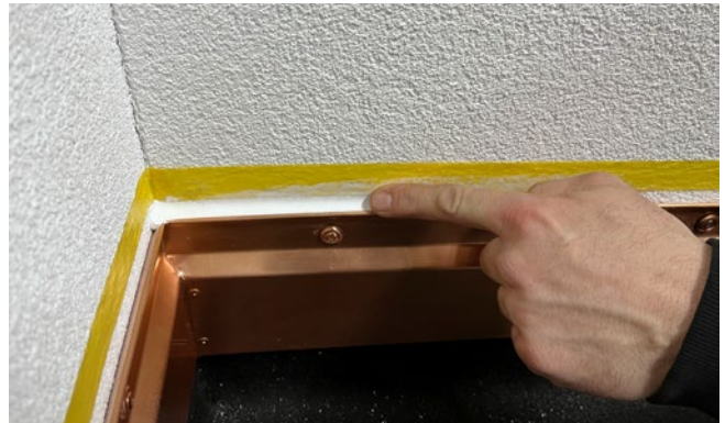
[ABB. 9] Die Fuge wird mit dem Finger und geeignetem Abglättmittel abgezogen.
