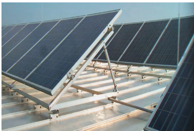
[ABB. 3] Aufgeständerte Anlagen generieren höhere Lasten als parallel aufliegende Anlagen, da sie dem Wind eine grössere Angriffsfläche bieten. Zudem können sich Schneemassen hinter den Modulen sammeln, welche die Haften zusätzlich belasten. Diese Anlagen sind individuell durch einen Statiker zu berechnen.
