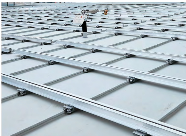
[ABB. 11] Unterkonstruktion mit ersichtlicher Begrenzung der Profillängen.
