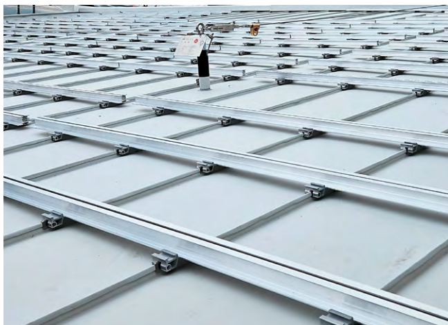
[ABB. 11] Unterkonstruktion mit ersichtlicher Begrenzung der Profillängen.
