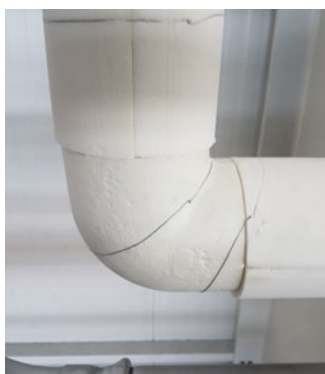
[FIG. 9] Isolation d'un coude au moyen d'un modèle préfabriqué en mousse.
