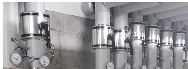
[FIG. 12] Dans la mesure du possible, les capots de vanne facilement démontables doivent être adaptés à l'isolation des conduites.
