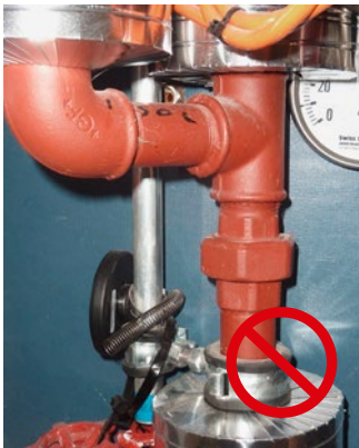
[FIG. 37] Isoler même les zones difficiles !
