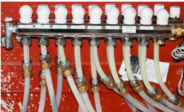
Distributeur pour chauffage au sol après rinçage/nettoyage
