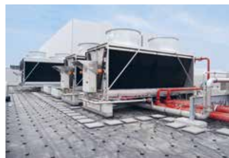
Illustration 7.16: Aéroréfrigérants hybrides. (Source: Jaeggi Hybrid-technologie AG)
