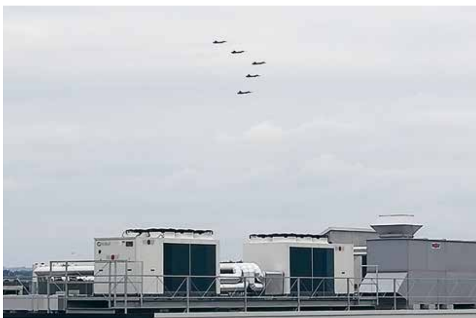
Illustration 7.7: Refroidisseur compact installé directement sur la toiture. (Photo: Wolf Schweiz AG)
