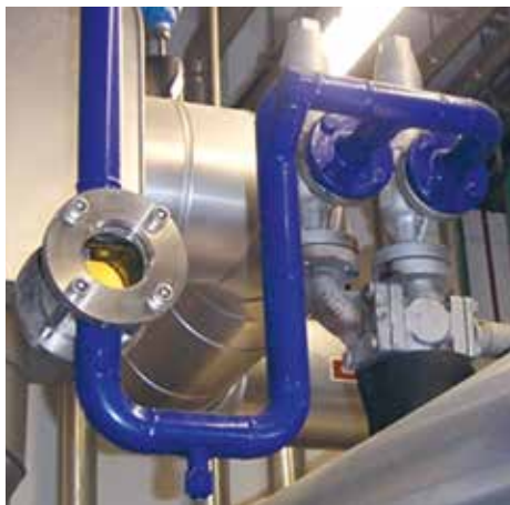
Illustration 5.31: Une variante possible avec un réservoir de glycérine et un regard, qui peut être utilisé pour vérifier les fuites.
