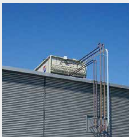
Illustration 5.27: Principe du condenseur direct comme exemple d'installation.
