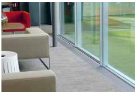
Illustration 6.4: Convecteur de climatisation, discrètement encastré dans le sol. (Source: Allco Allenspach AG)
