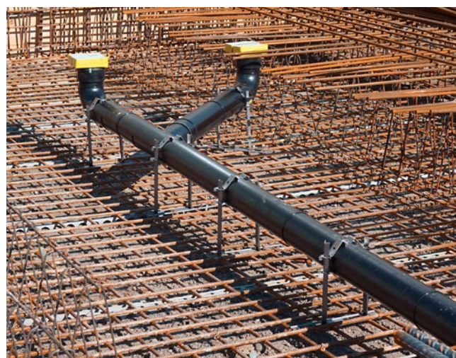
[FIG. 1] Exemple de collier de dalle pour plafond en béton apparent (Source : SAMVAZ SA).
