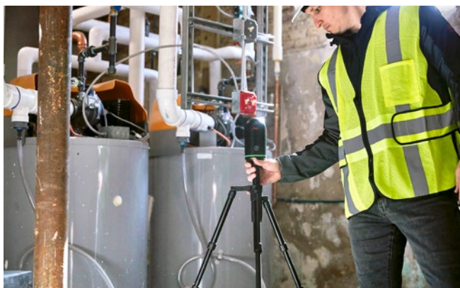
[FIG. 5] Processus de numérisation. (Source de l'image : Leica Geosystems)
