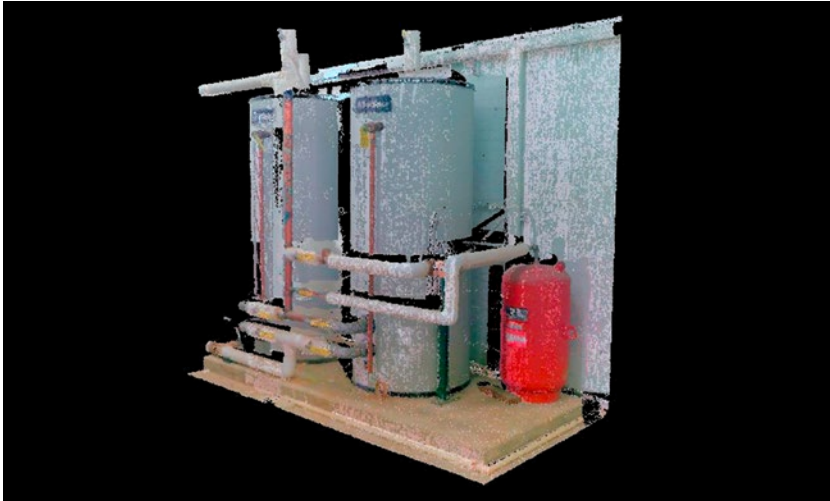
[FIG. 4] Nuage de points. (Source de l'image : Leica Geosystems)
