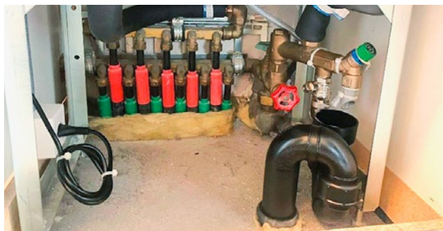
[FIG. 4] Installation sous le chauffe-eau PAC.
