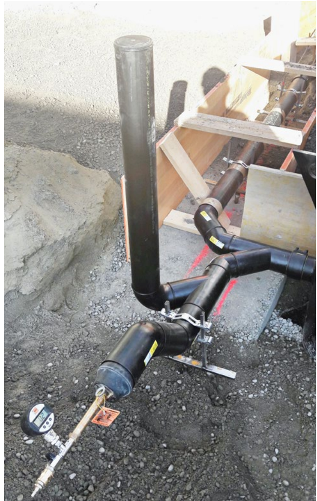
Ill. 2 : Essai de pression sur des collecteurs enterrés
