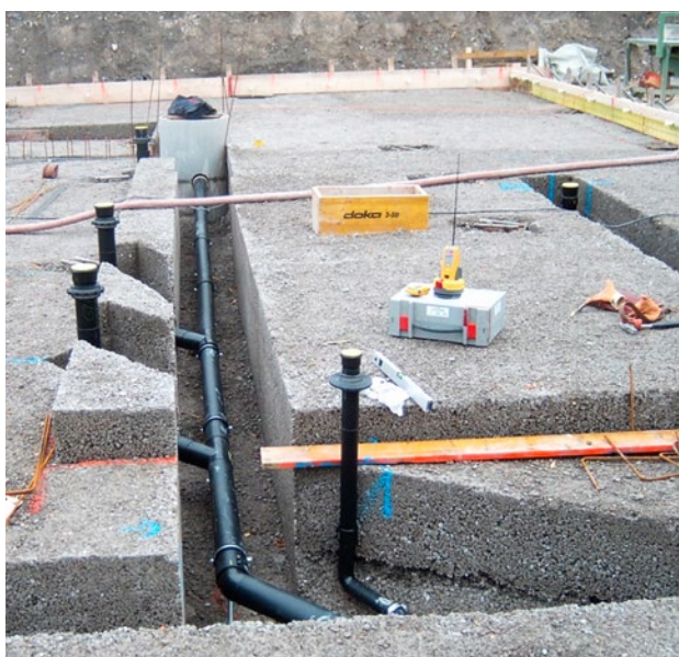
III. 12: Certains types de joints d'étanchéité à bague nécessitent un entretien régulier. Ils doivent donc être accessibles.
