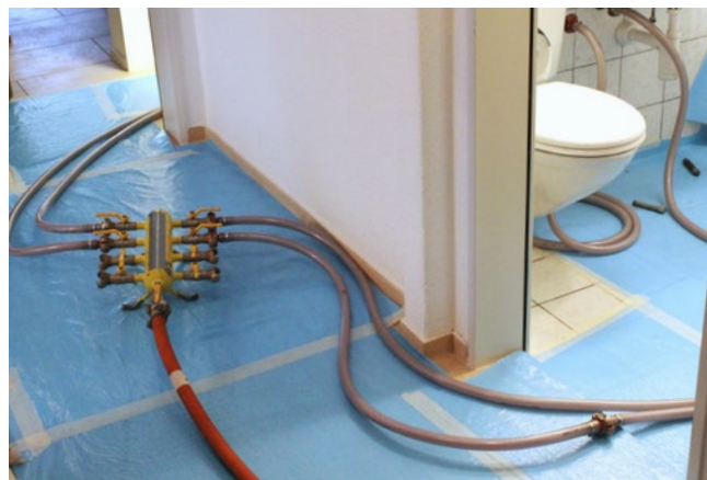
[FIG. 1] Assainissement intérieur des conduites dans un bâtiment d'habitation.
