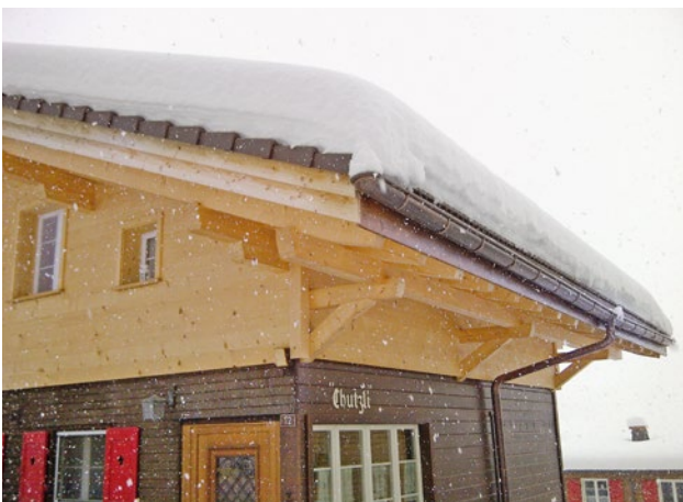
Illustration 16 : avant-toit isolé, presque pas d'eau de refoulement
