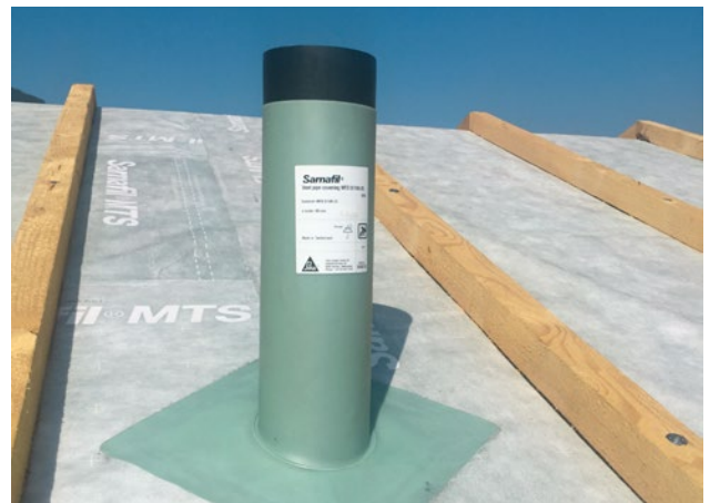
Illustration 10 : pièce spéciale soudée
