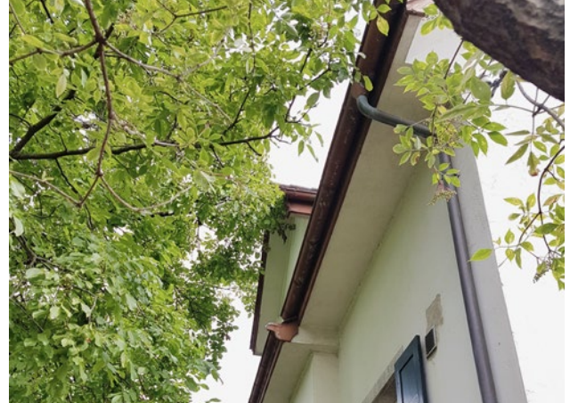
Illustration 11 : sous-face en plâtre sensible à l'humidité
