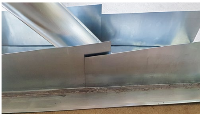
[FIG. 7] Abergements en alliage de zinc ou cuivre, épaisseur 0,3 mm.
