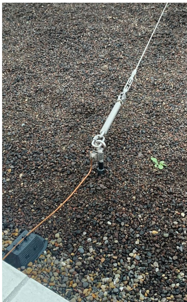
[FIG. 6] Point final raccordé.
