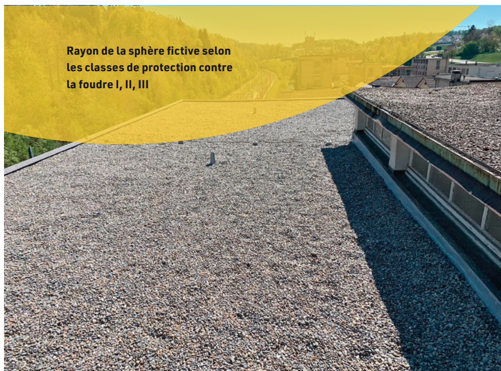
[FIG. 1] Le point d'ancrage individuel est protégé par le rayon de la sphère fictive et ne doit pas être raccordé.
