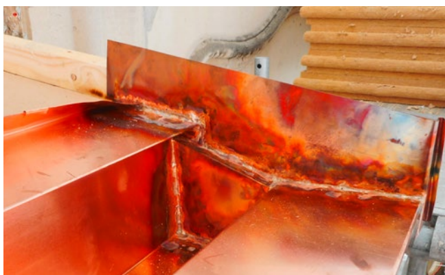
[FIG. 4] Brasage forte près d'un élément de construction en bois : on peut contrôler le travail en soulevant le chéneau une nouvelle fois.
