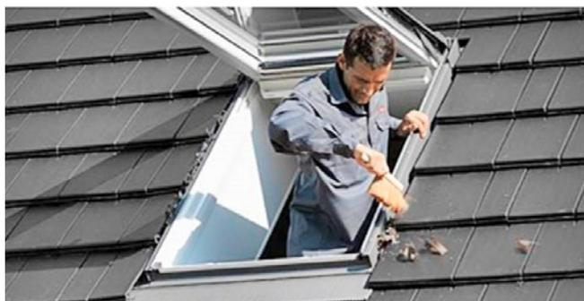
**[FIG. 2]** Risque accru d'infiltration d'eau aux raccords en raison de l'encrassement.
