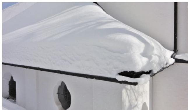
**[FIG. 9]** Les charges de neige et de vent s'exercent sur la structure porteuse, la contre-latte et la couche de support.
