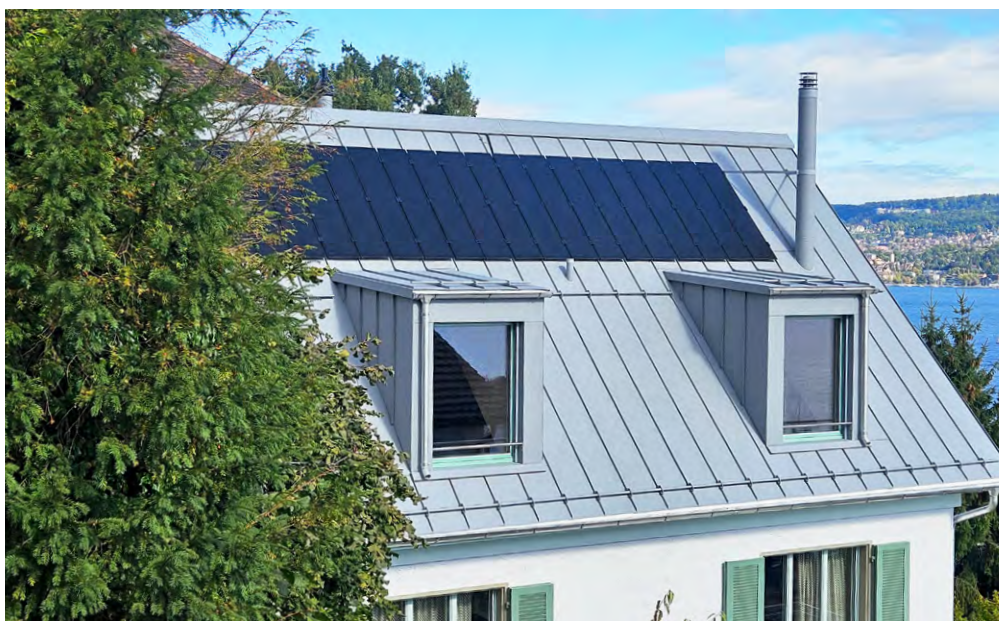
[FIG. 10] Installation solaire avec dispositif de retenue de neige.
