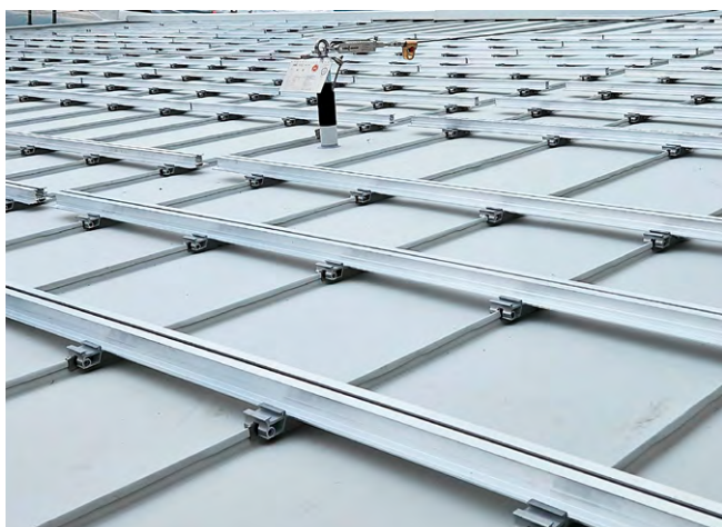
[FIG. 11] Sous-construction avec limitation visible de la longueur de profil.
