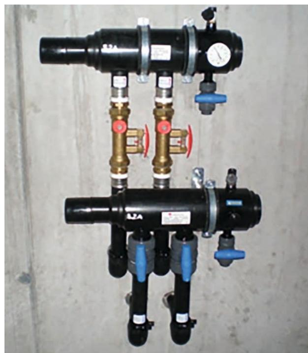
Distributore/collettore con due sonde geotermiche
