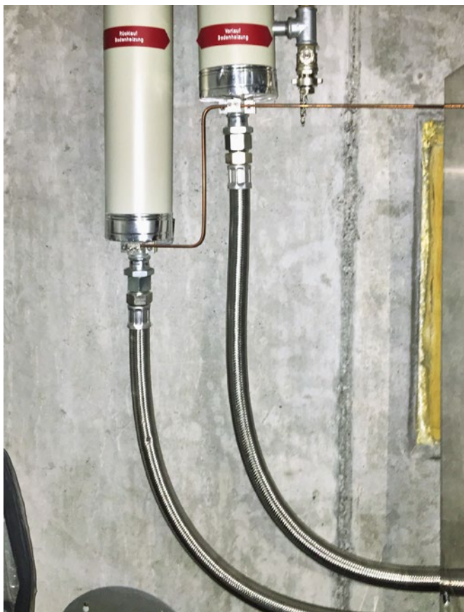
[FIG. 1] Pompa di calore con collegamenti in EPDM non ermetici alla diffusione di ossigeno.
