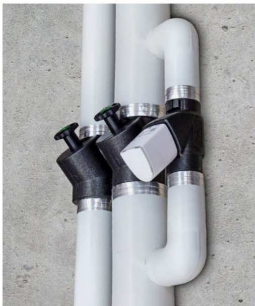
[FIG. 8] Colonna montante con circolazione TcT e valvola di regolazione elettronica.
