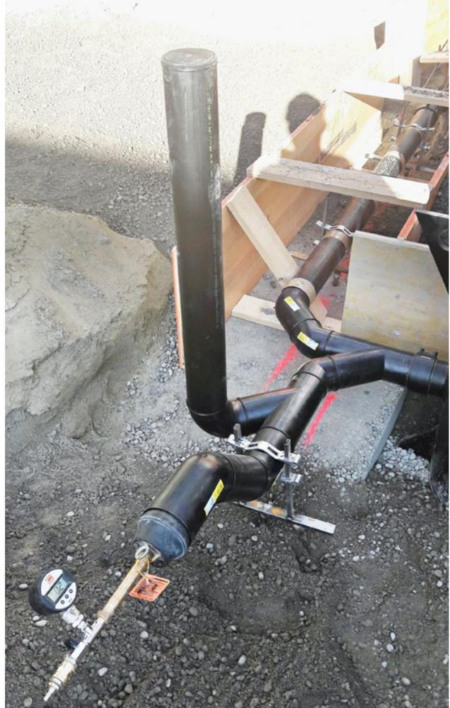
Fig. 2: Prova a pressione dei collettori di fondo
