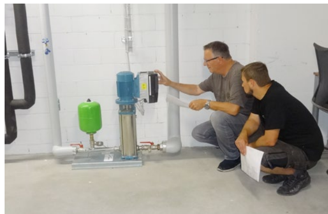
[FIG. 3] Secondo le direttive dell'ordinanza sull'acqua potabile, il proprietario/gestore dell'impianto d'acqua potabile è responsabile del corretto esercizio dell'impianto. Affinché questi sia in grado di adempiere ai suoi obblighi, il realizzatore dell'impianto è tenuto a istruire il proprietario/gestore dell'impianto. Ciò include la consegna dei documenti dell'impianto e una spiegazione con i verbali d'istruzione.
