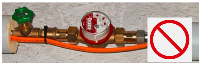
[FIG. 3] Il nastro riscaldante deve essere montato in basso alla base del tubo.
