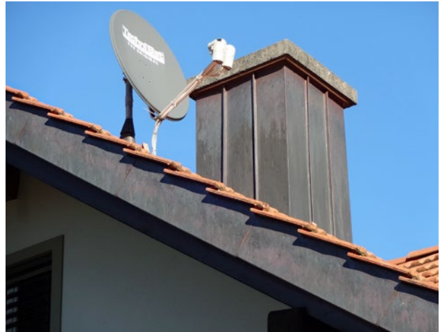
Estetica/aspetto dopo una grandinata: casa con opera da lattoniere di rame – Aspetto allo stato nuovo e dopo formazione della patina (a destra)
