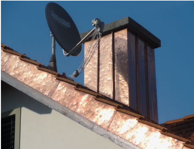
Estetica/aspetto dopo una grandinata: casa con opera da lattoniere di rame – Aspetto allo stato nuovo e dopo formazione della patina (a destra)
