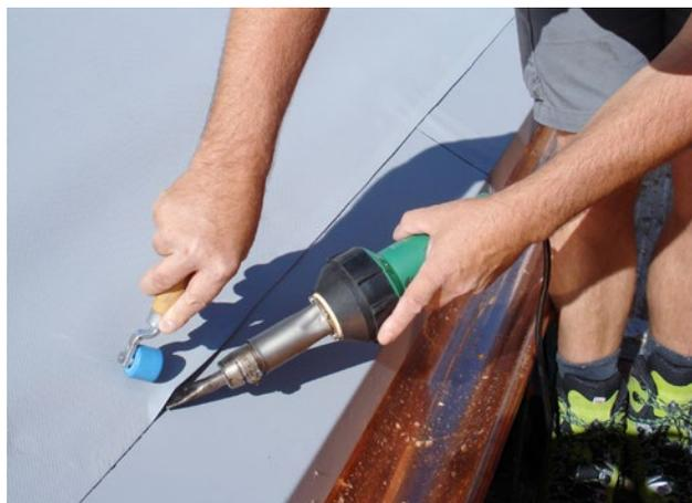
Figura 13: Manto per sottotetto su scossalina rivestita. I giunti sulla scossalina devono essere saldati.
