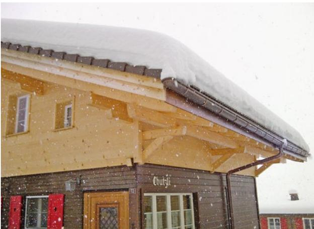
Figura 16: Tettoia isolata, assenza quasi totale di acqua di respingimento
