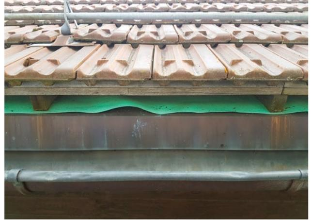
Figura 17: Manto per sottotetto non sufficientemente protetto
