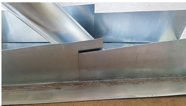
[FIG. 7] Casi pratici di raccordi con linguette, esecuzioni con leghe in lamiera di zinco o rame, spessore 0,3 mm
