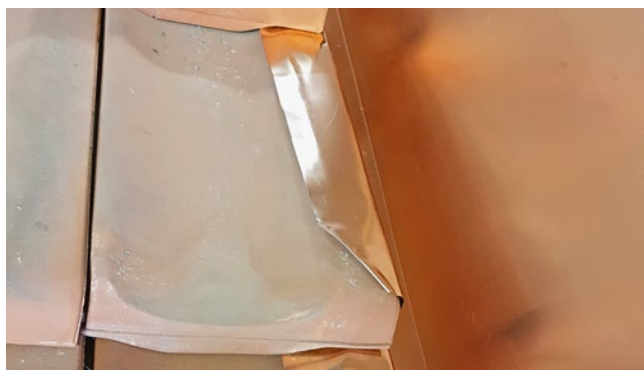
[FIG. 7] Casi pratici di raccordi con linguette, esecuzioni con leghe in lamiera di zinco o rame, spessore 0,3 mm
