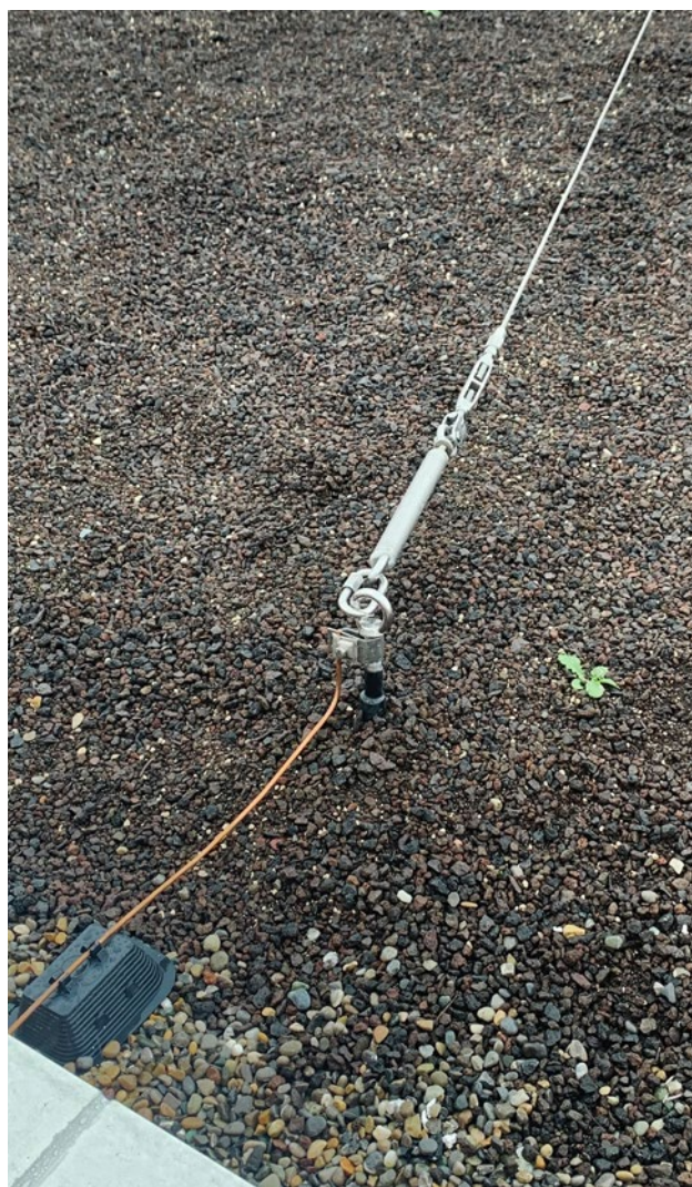
[FIG. 6] Punto di arrivo del sistema anticaduta raccordato.
