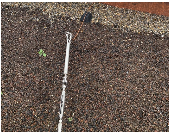
[FIG. 5] Il sistema anticaduta non si trova nell'angolo di protezione e quindi il punto di partenza o di arrivo deve essere raccordato.
