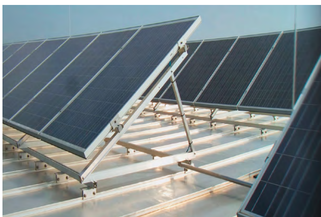
[FIG. 3] Gli impianti sollevati producono carichi superiori rispetto a quelli aderenti al tetto, poiché espongono al vento una superficie maggiore. Inoltre, dietro i moduli possono accumularsi masse di neve che aumentano le sollecitazioni sui ganci di ancoraggio. Tali impianti richiedono un calcolo specifico da parte di un esperto di statica.
