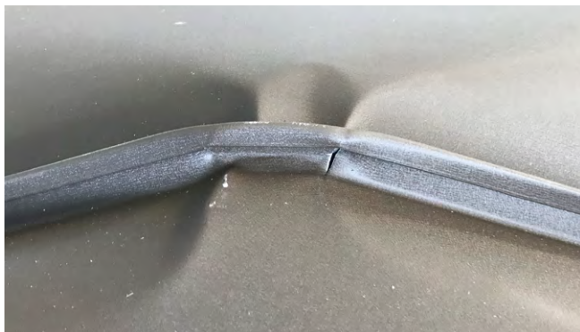
[FIG. 1] Deformazione dell'aggraffatura verticale doppia a causa dell'aumento dei carichi dovuti agli impianti solari (pressione dinamica del vento, incremento del peso proprio, pressione della neve sulla falda).
