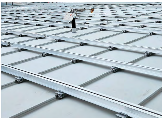
[FIG. 11] Sottostruttura con evidenti interruzioni dei profili.
